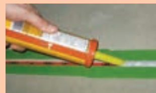
7 Pose du scellant adhésif flexible
