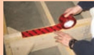
1 Pose sur ruban pare-adhérence
