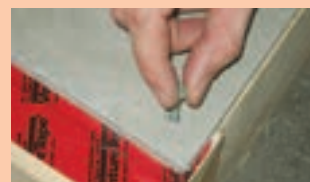
4 Trou plus grand que le diamètre de la vis
